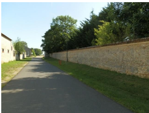
36) Mur d'enceinte du parc du château
